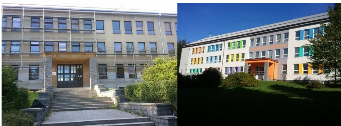
Obr. 2: ZŠ Smetanova před a po rekonstrukci
