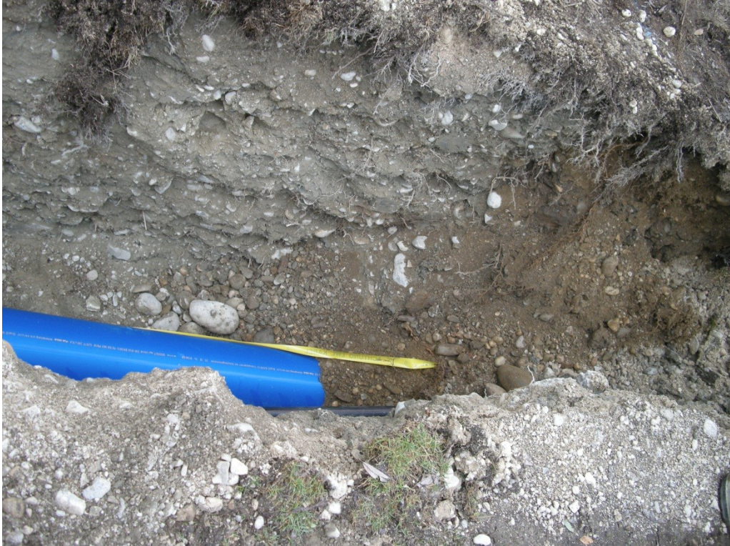
Obr. 2: instalace vodovodního potrubí DN 300, kabelu a chráničky.
