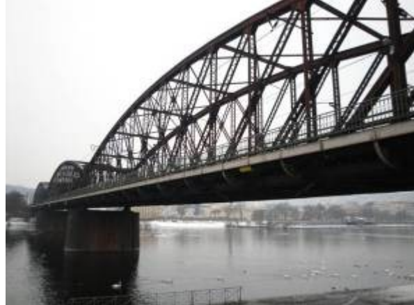
d) zavěšení na mostní konstrukci
