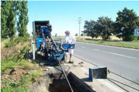
a) technologie řízeného protlaku
