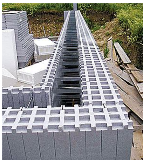
Obr. 4: Bednicí systém z polystyrénových tvarovek
