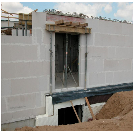
Obr. 3: Masivní konstrukce z pórobetonových cihel
