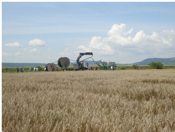
Obr. 2: Metoda Pluhování, pokládka 2 ks tří-žilových kabelů VN 22kV, Šakvice 2010
