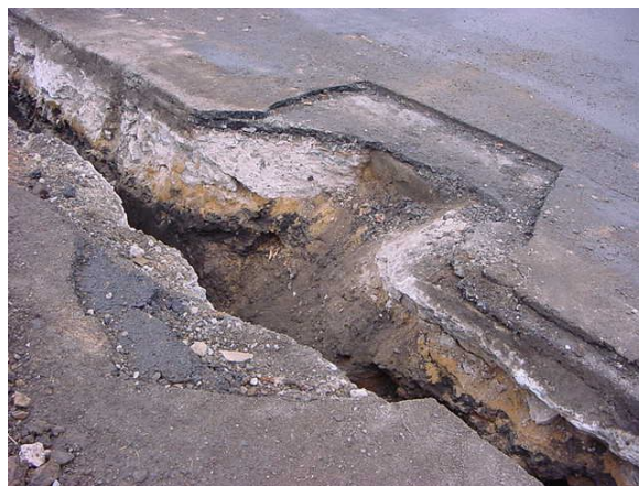
e) realizace do konstrukce vozovky
