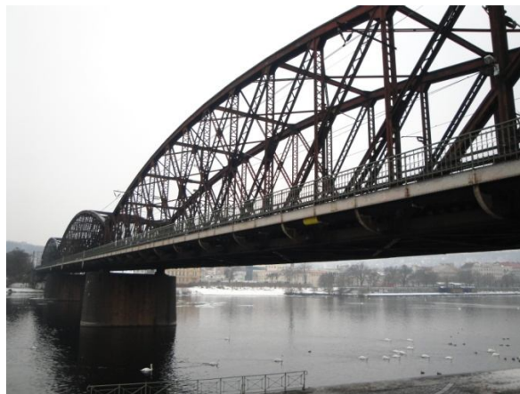
d) zavěšení na mostní konstrukci
